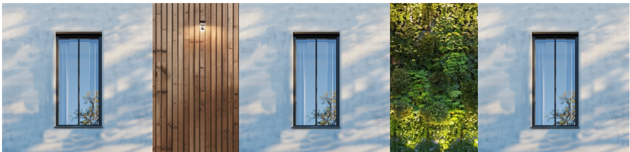
Exempel på hur fasaden kan brytas av med olika material och element i vertikala utformning som skapar en uppdelad, harmonisk och lekfull helhet där materialerna kompletterar varandra.
