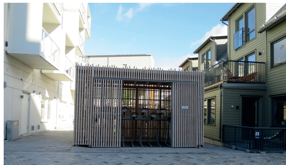
Cykelförvaringsplats i Vallastaden, Linköping.
